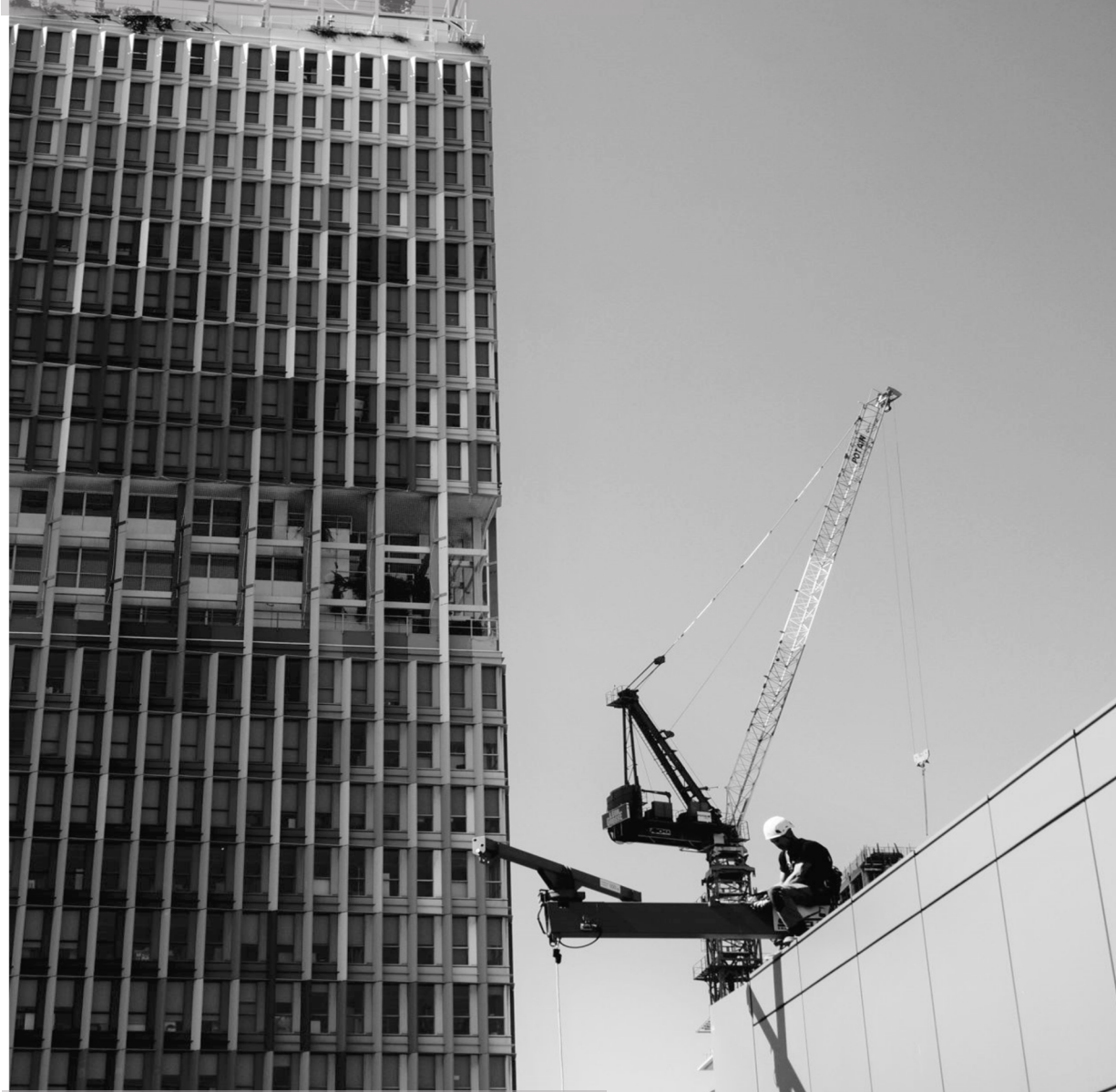
Installation d'une nacelle permanente
